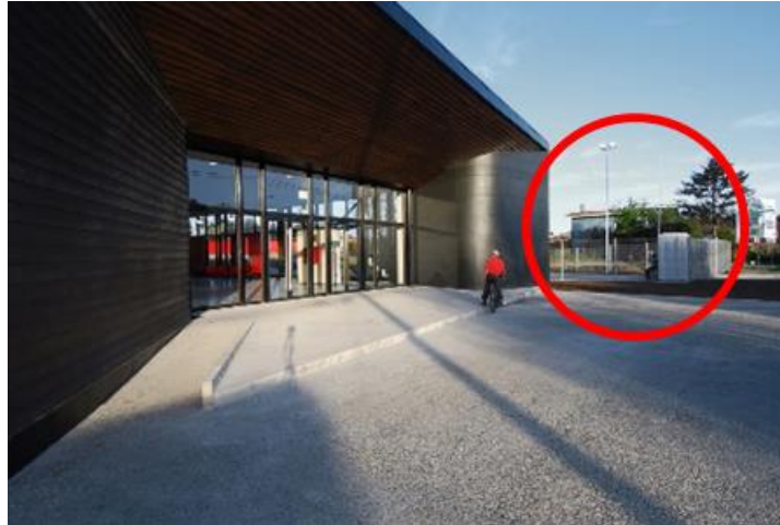
Figura 38. Identificación de construcción aledaña terminal de buses Los Lagos, elaborada por el autor del trabajo con base en los planos de la plataforma Archidaily.
