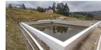
Filtración Lenta en Arena (FLA)
