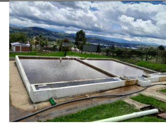
Filtración Lenta en Arena (FLA)
