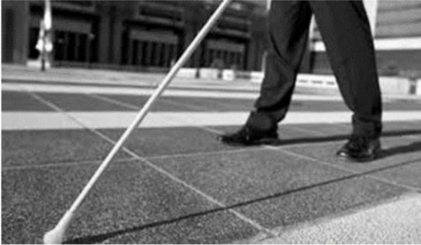
*Nota:* La figura muestra los pavimentos táctiles. Fuente: pavimentos táctiles: un lenguaje urbano necesario (s.f).
