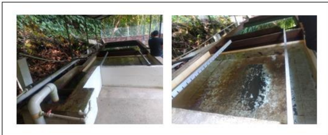
Figura 13. Estructura cámara de aquietamiento PTAP Pajarito Boyacá, fuente: autor.
