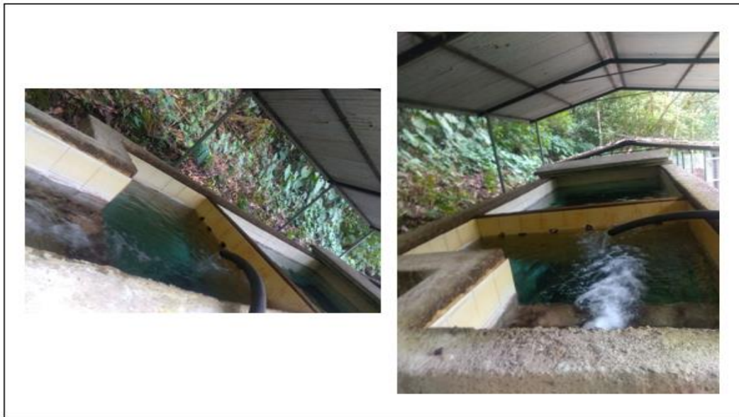
Figura 10. Estructura desarenador PTAP Pajarito Boyacá, fuente: autor.
