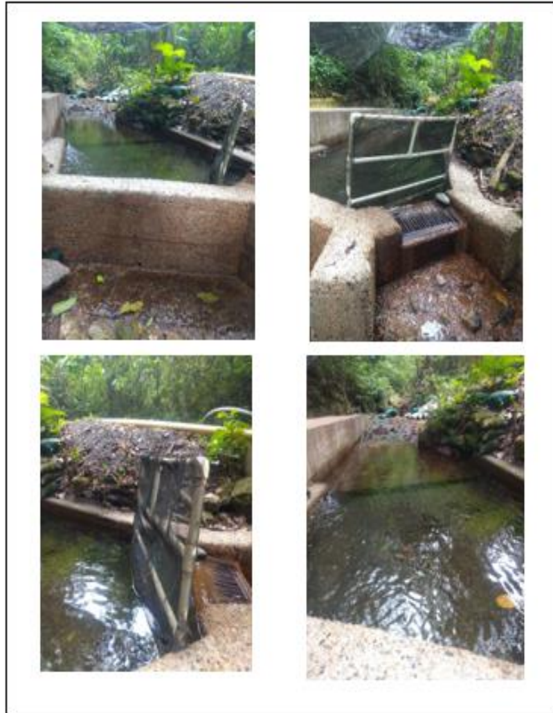
Figura 8. Bocatoma o punto de captación PTAP Pajarito Boyacá, Fuente: autor.
