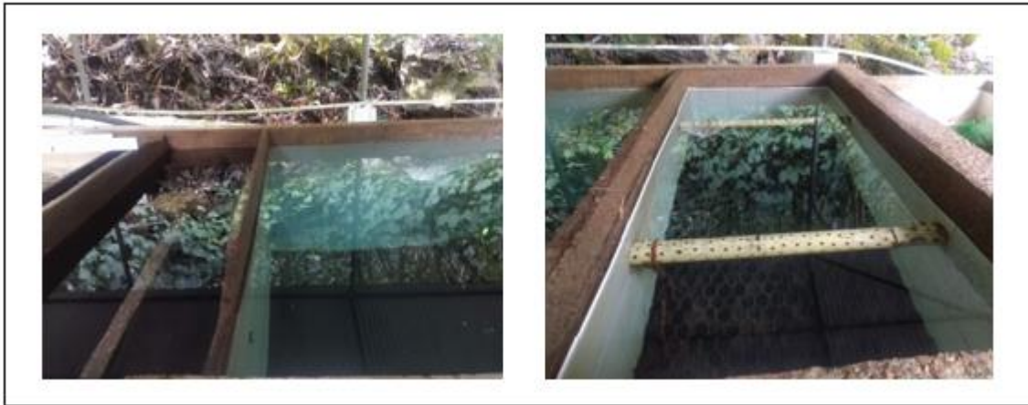
Figura 14. Estructura sedimentación PTAP Pajarito Boyacá, fuente: autor.
